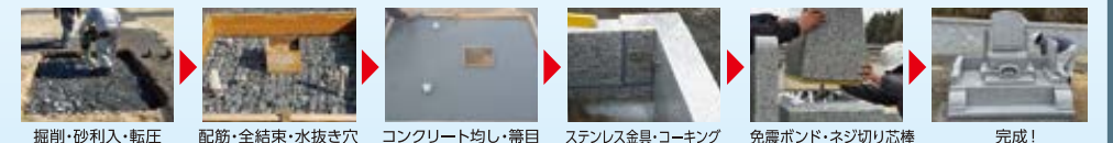
掘削・砂利入・転圧 配筋・全結束・水抜き穴 コンクリート均し・帯目 ステンレス金具・コーキング 免震ボンド・ネジ切り芯棒 完成!
